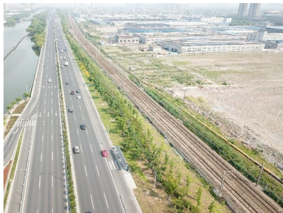
(18) K0+800 右侧临时工棚，现为道路绿化
