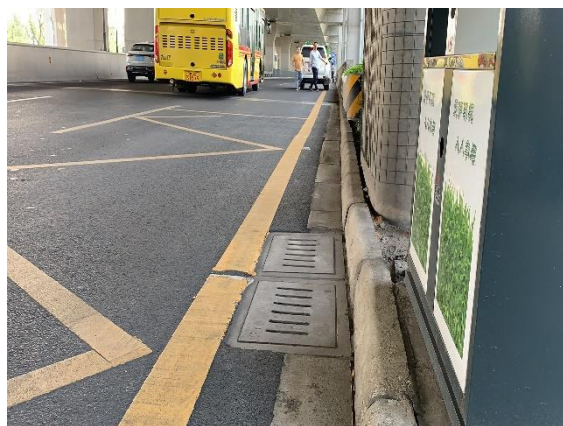
(6) 主线排水（市政雨水管）2
