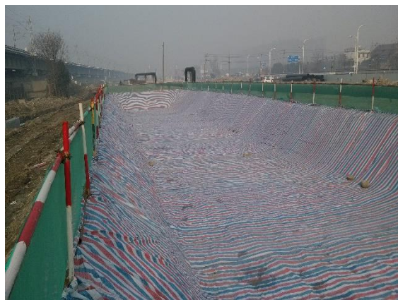
(2) 钻渣泥浆池防护 1
