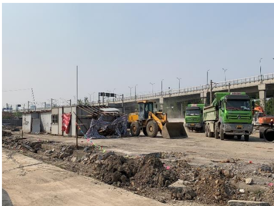
(19)弥陀道口与原既有线东北角,梁场、拌合站已归还, 现由其他项目使用
