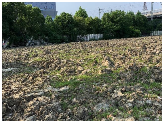
(20)彪佳路与湖滨路东北角临建拆除, 撒播草籽绿化
