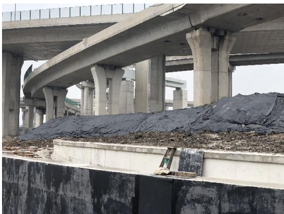
(1) 剥离表土密目网覆盖
