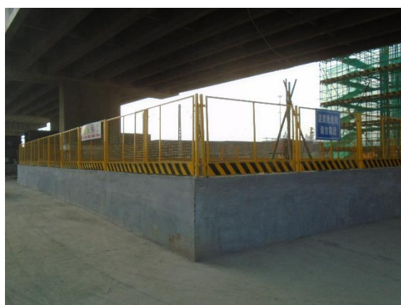
(4) 钻渣泥浆沉淀池防护 3
