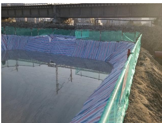
(3) 钻渣泥浆沉淀池防护 2
